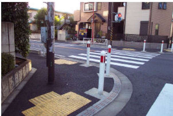
▲ 道路照明柱がもろに歩道内障害位置
